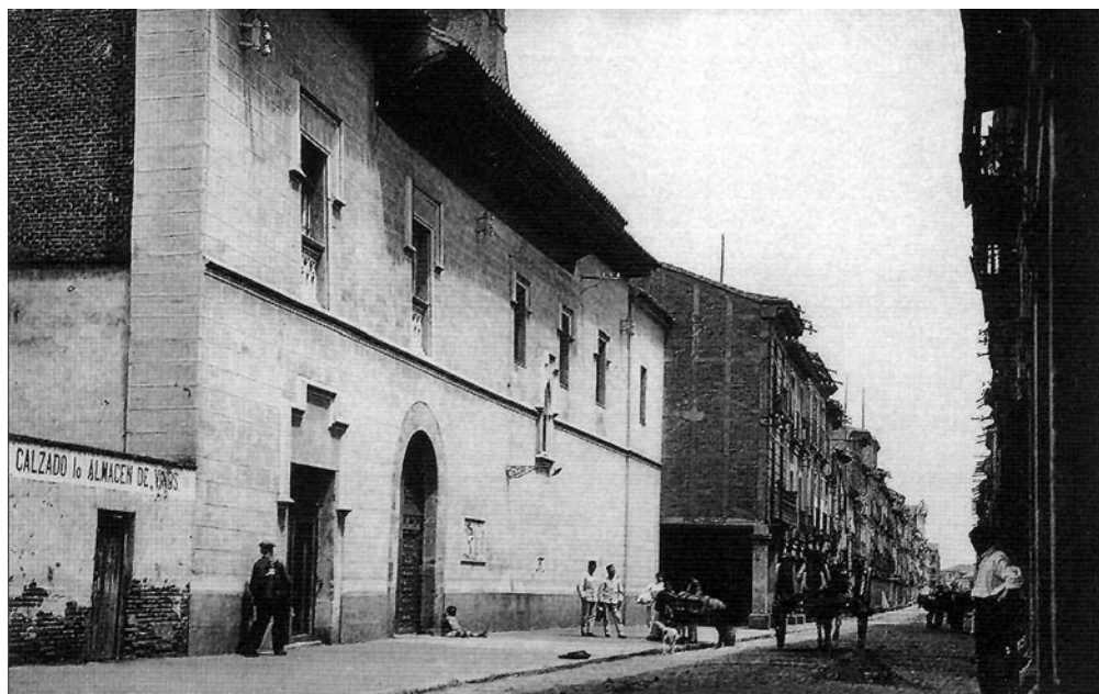
Postal de Hauser y Menet (hacia 1910), con la calle Mayor de Alcalá de Henares y el Hospital de Antezana.
